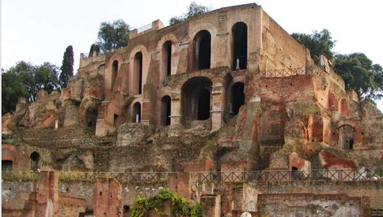
I antikkens Roma, ble ikke engang forskalingen revet. Heldigvis, for da marmoren var vekk kom vakre teglvegger til syne. Fra Palatinerhøyden, den sentrale av Romas syv høyder og den eldste delen av byen
