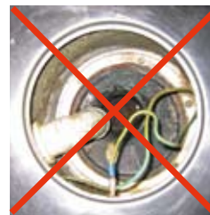
Bilde 1: Ikke slik: Jordingskabel skal ikke ligge åpent i sluket
