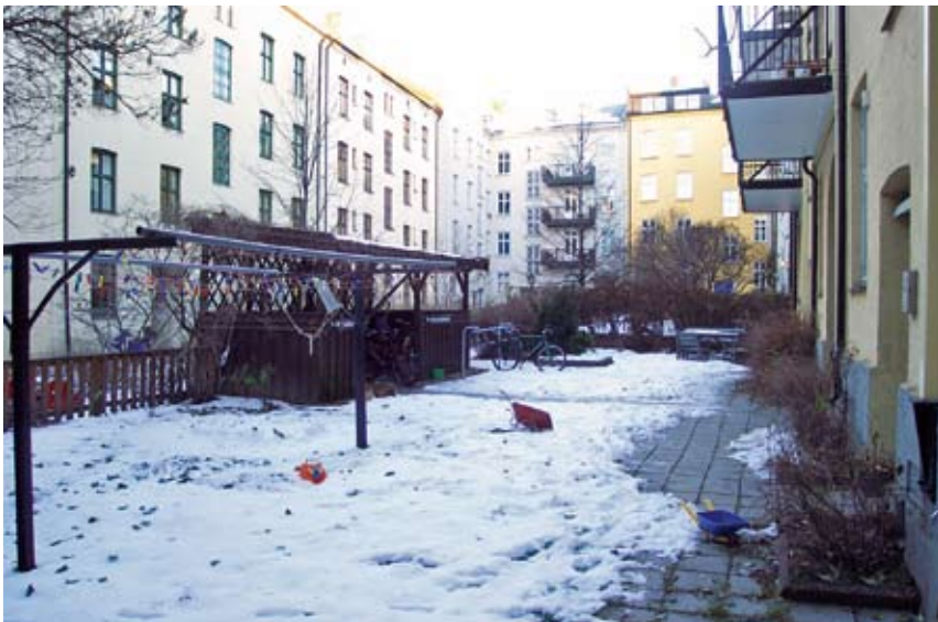
Arbeidene med etablering av fuktsperre langs fasaden og nye balkonger hadde etterlatt gårdsrommet i Markveien 23 i en sørgelig forfatning
