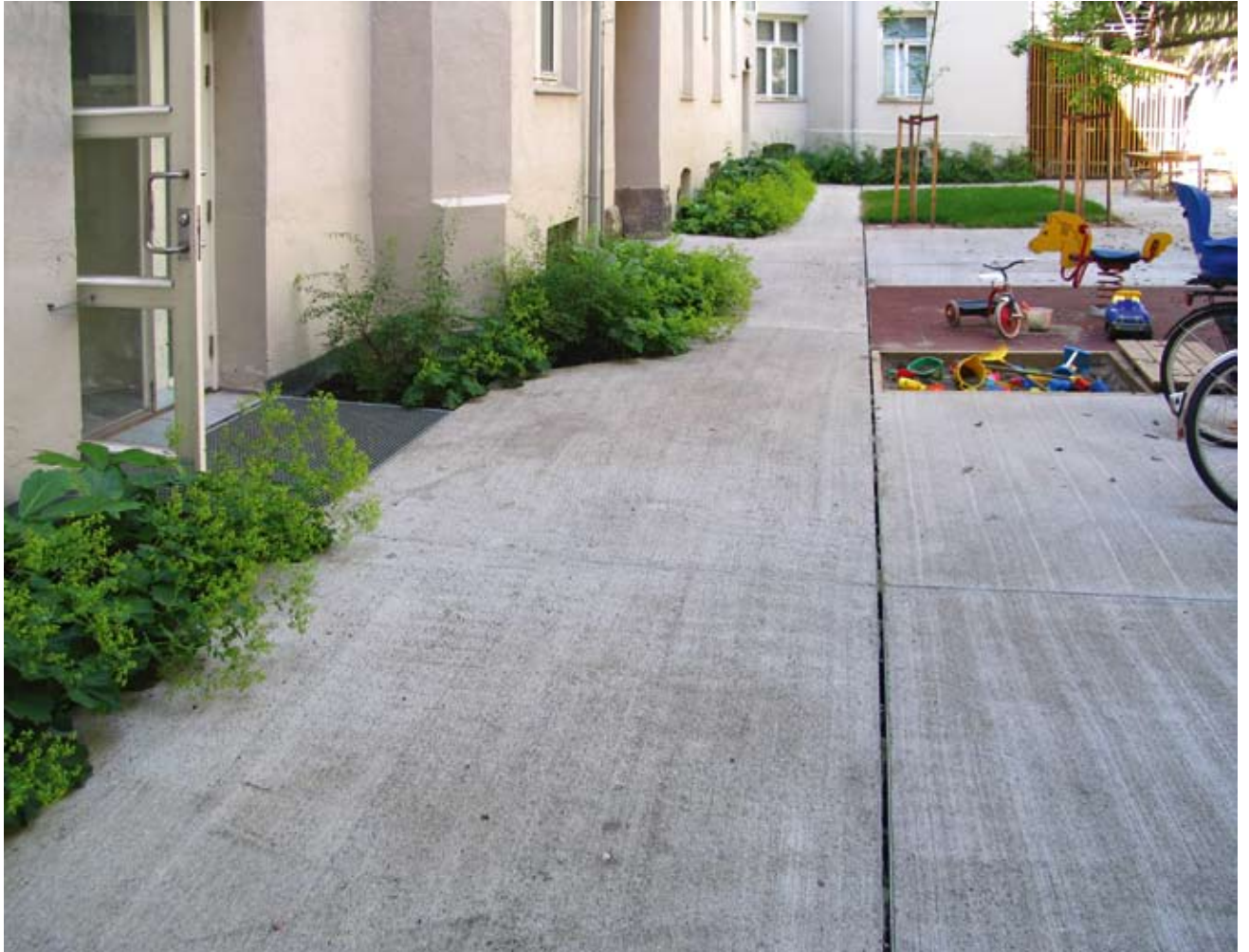
Gårdsrommet i Marselisgate 31 etter rehabilitering
