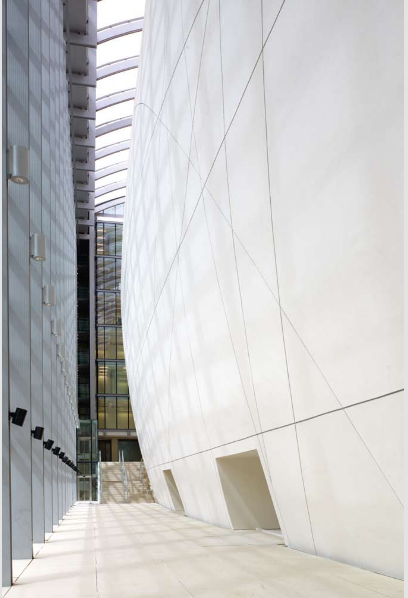
Skallet, syv etasjer høyt og ca 60 meter langt, rommer samlinger som skal beskyttes mot dagslys og andre klimatiske påkjenninger. Selve skallet er 30 cm tykt og støpt i Shotcrete sprøytebetong på armeringsnett. Overflaten er en meget fin elfenbensfarget finpuss.
