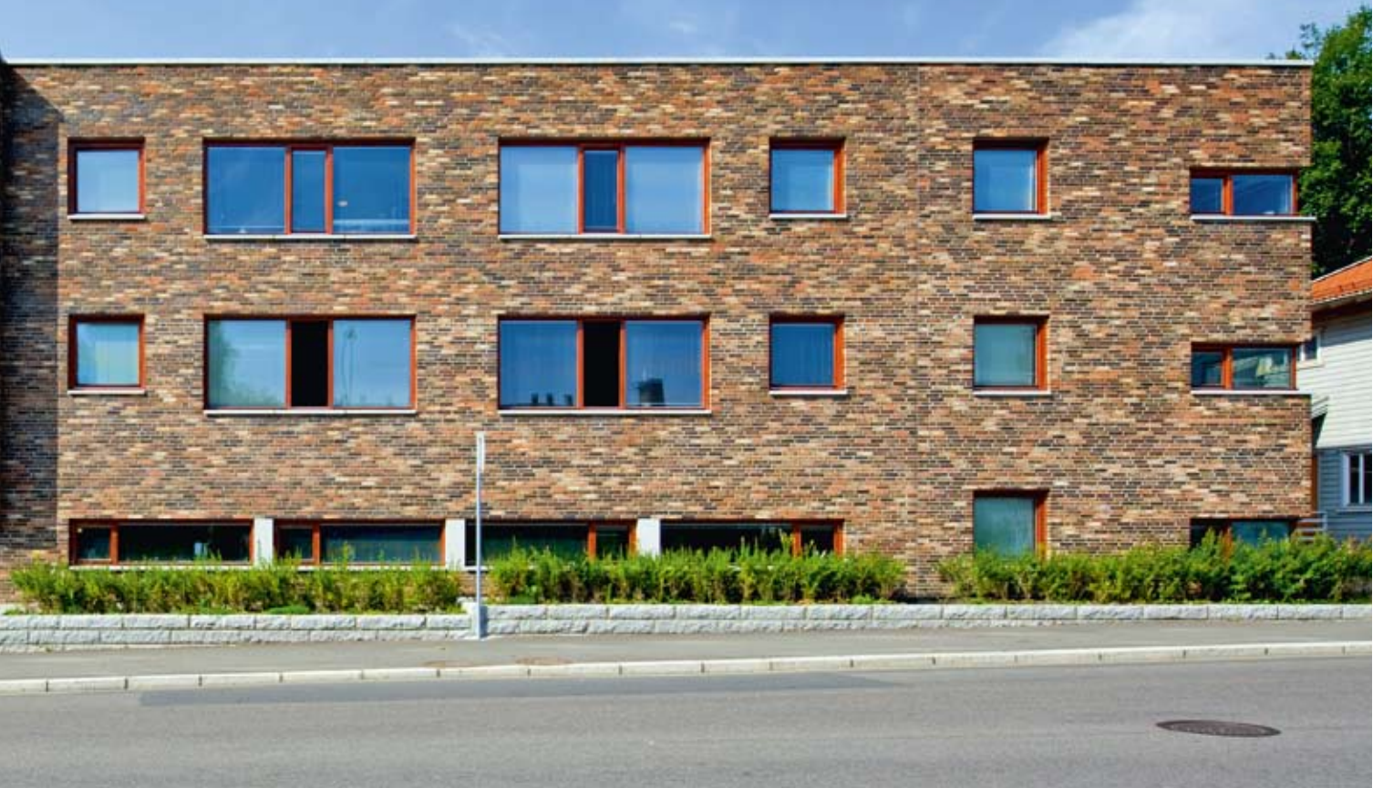
Fasade mot øst - Maridalsveien
