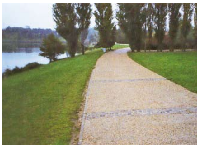
Gangvei med frilagt betongoverflate.
