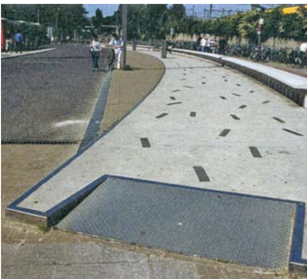
Innfelt materiale. Fiberoptikk leder lys til betongoverflaten og danner alt fra mønster til budskap.
