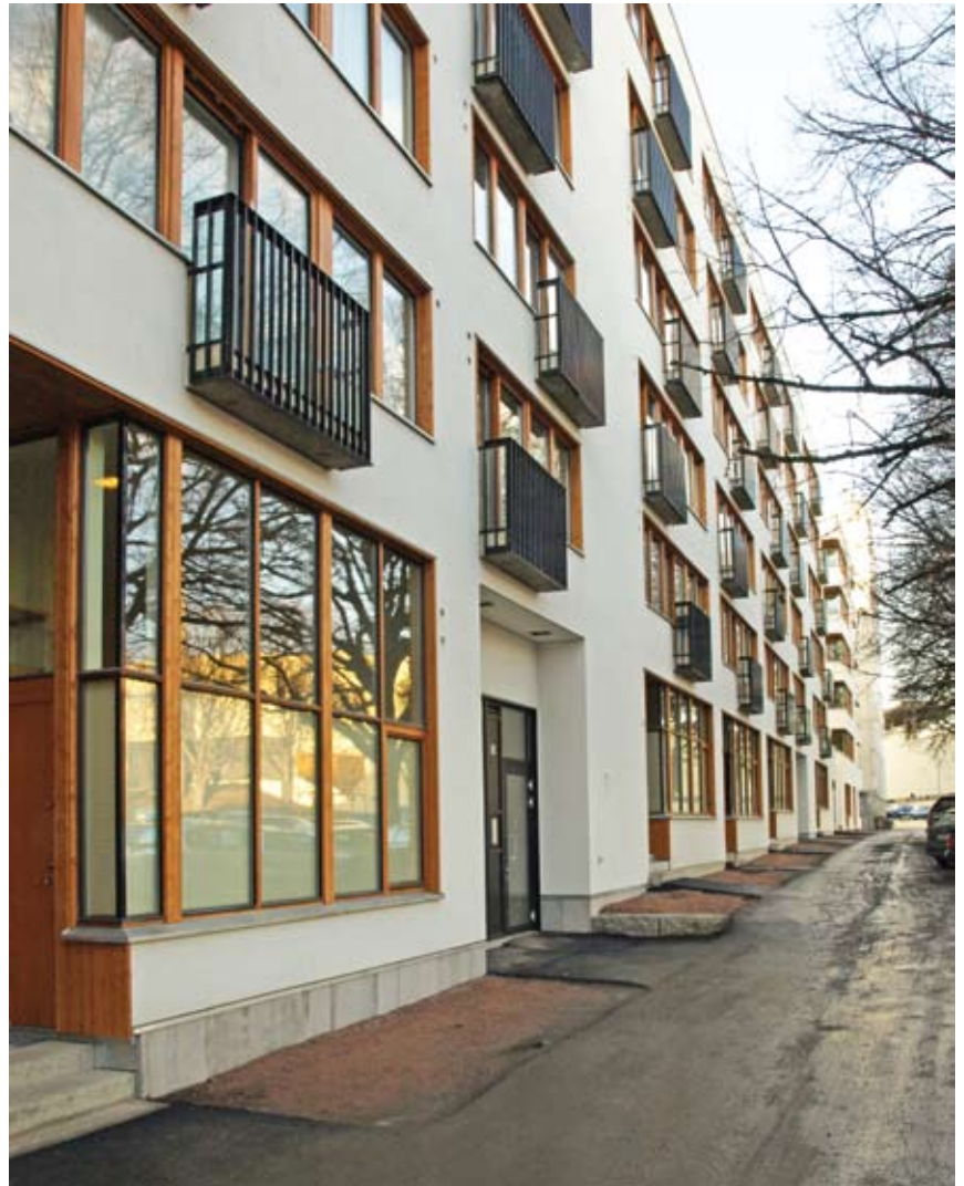
Fasade mot Lille Bislett idrettsplass. Leiligheter med egen inngang på plan 1, leiligheter oppover med franske balkonger mot de flotte trærne
