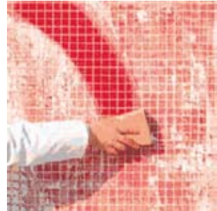
Slik monteres mosaikk med papir eller folie på fremsiden. Limet påføres, arket arbeides godt inn i limet. Etter noe tørketid fjernes papiret. Én teknikk går ut på å lime og fuge med samme produkt. Da slipper man fargenyanser selv om limet er presset opp i fugene.
