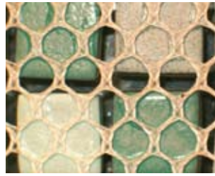
Nettet limes til brikkene med vannløselig lim og minsker vedheftsflaten mellom flislim og glassbrikke
