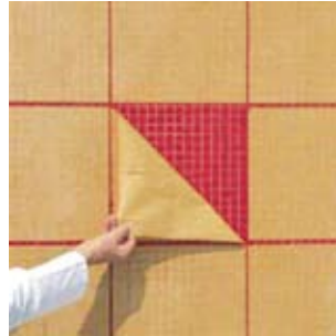
Slik monteres mosaikk med papir eller folie på fremsiden. Limet påføres, arket arbeides godt inn i limet. Etter noe tørketid fjernes papiret. Én teknikk går ut på å lime og fuge med samme produkt. Da slipper man fargenyanser selv om limet er presset opp i fugene.
