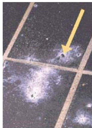
Bilde A: Alkalireaksjoner med overflateavskallinger og utfellinger
