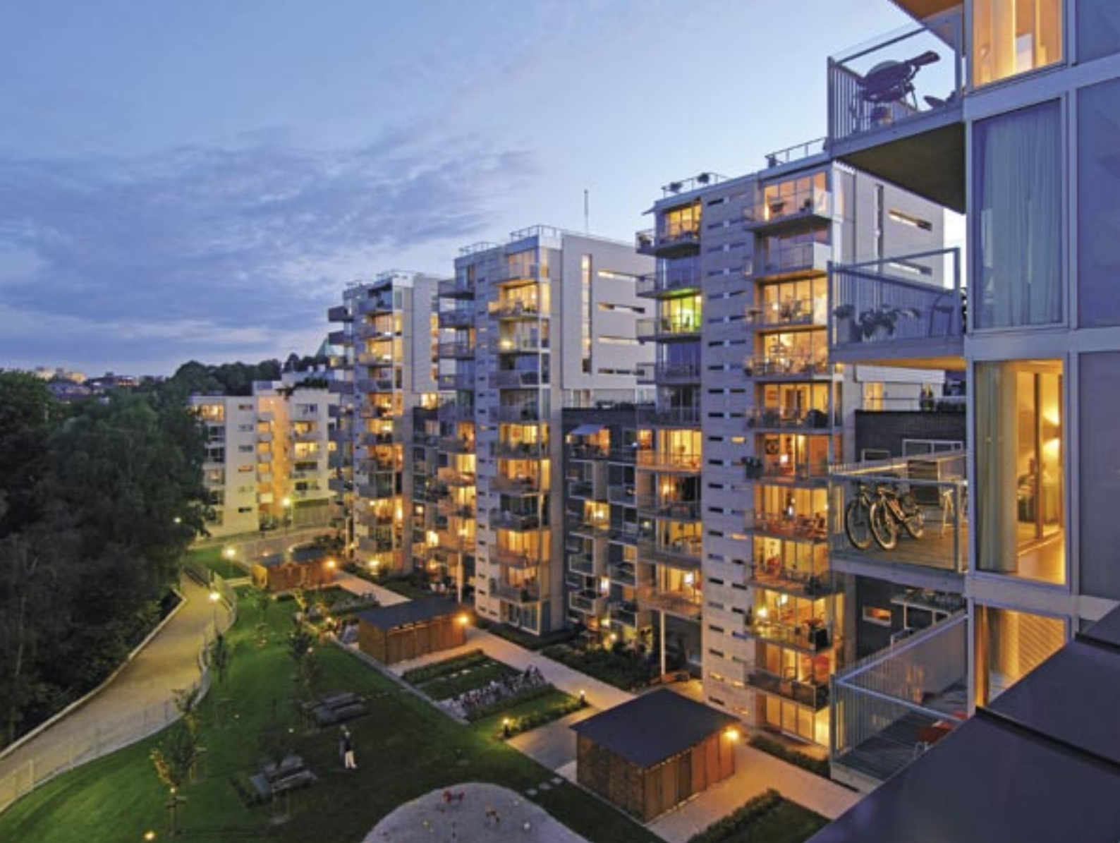
Leilighetene åpner seg mot hagen og elverommet. De karakteriske betongfeltene i tårnfasaden har horisontale vinduer i to høyder pr. leilighet
