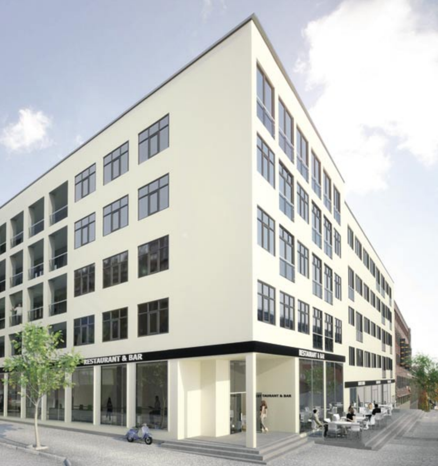
Fasade sett fra hjørnet Trondheimsveien/Konghellegata
