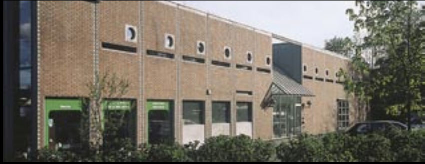
Kontor-/næringsbygg La-Sa Maritim, tegl i betongelementer, Oslo (84) Einar Dahle Arkitekter. Betongelementprisen 1987
