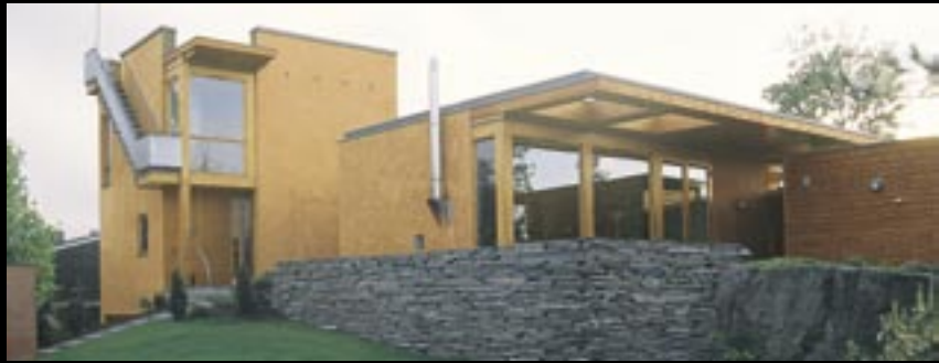
Enebolig, Stavern (94) Einar Dahle Arkitekter
