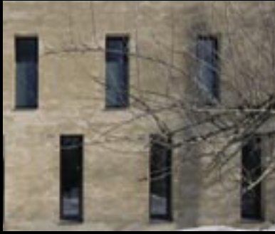
Tilbygg enebolig, Oslo (05) Dahle/Dahle/Breitenstein
