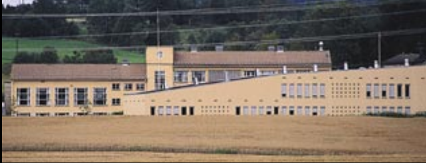
Ås skole, Eidsvoll, tilbygg (00) Dahle/Dahle/arkitekter m/ ark. Kurt Breitenstein
