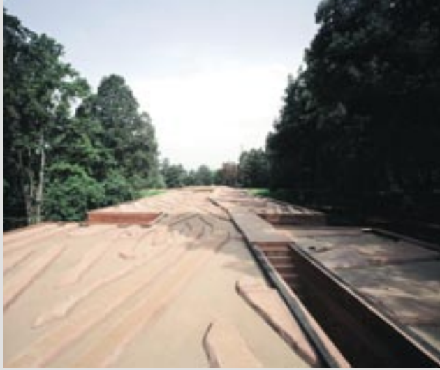
På takflaten sørger grunne utgravde kanaler (som i de kunstige hollandske landskap) for at vannet ledes bort i kontrollerte former
