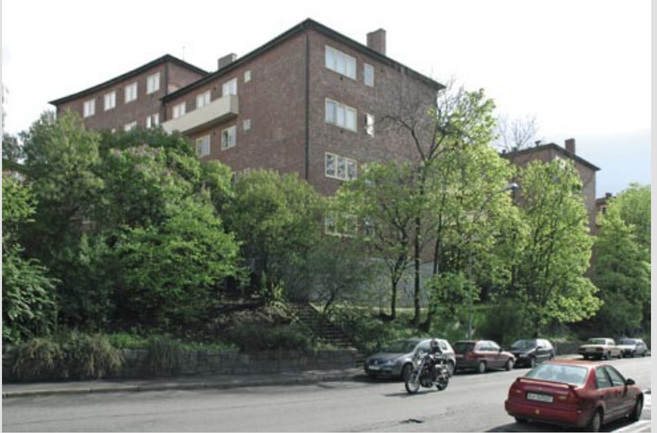
Lamellene mot nordvest åpner for «trappeblokken»
