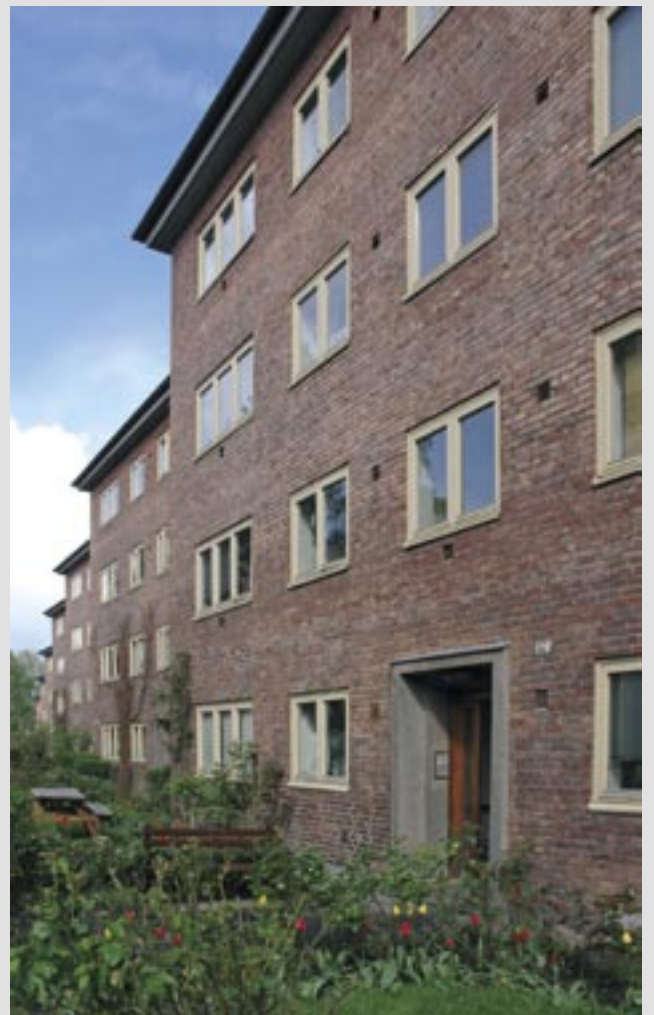
«Trappeblokkens» fasade mot nordvest
