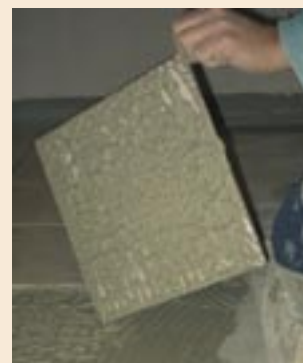
Kontrollér at det er full limdekning med «slakteprøven»; en flis trykkes ned i limet og dras opp igjen.
