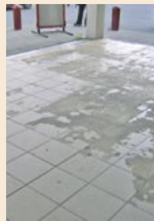
Bruk frobestandige fliser. Unngå glasserte fliser hvis ikke leverandøren kan garantere de holder i vårt klima.
