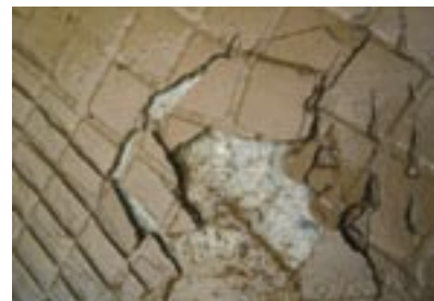
Figur 4: Vær nøye med underlaget. Det finnes sparkel- og avretningsmasser som ikke kan ligge fuktexponert utendørs. De sveller, fryser i stykker og smuldrer opp.
