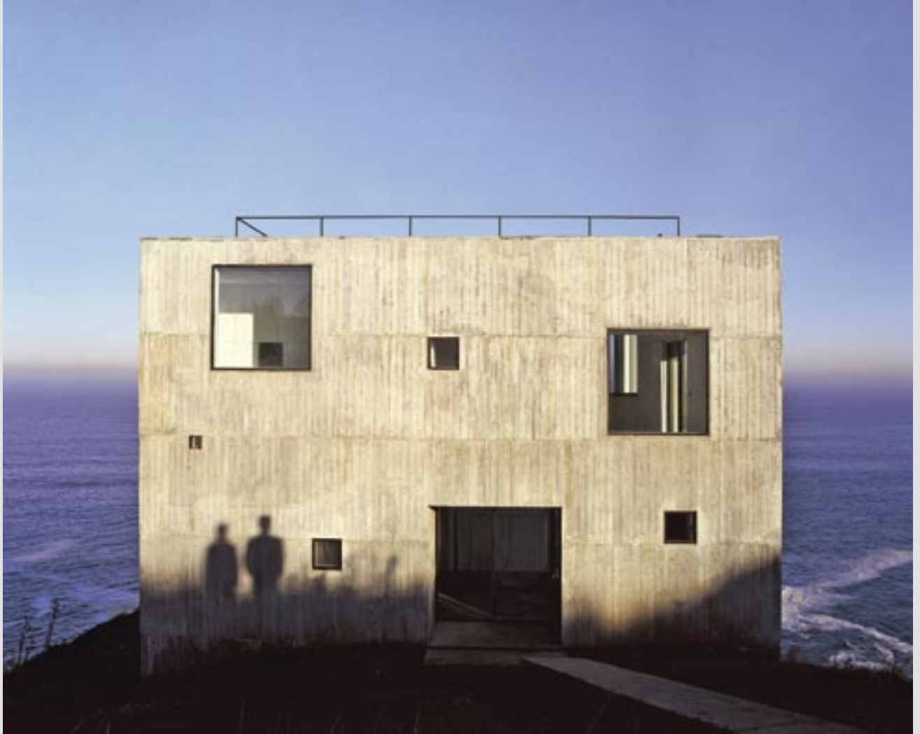
Utvendig står betongen i sin grå egenfarge og egenstofflighet preget av de grove forskalingsbordene
