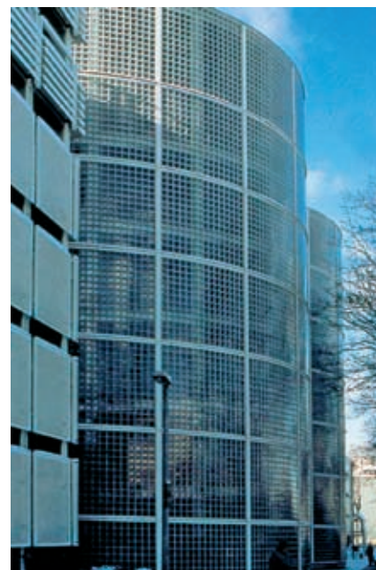
Figur 7: Prefabrikkerte elementer med glassbyggestein
