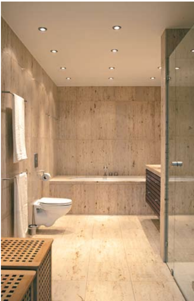
På badet i sokkel-etasje er gulv og vegger belagt med kalksteinsplater
