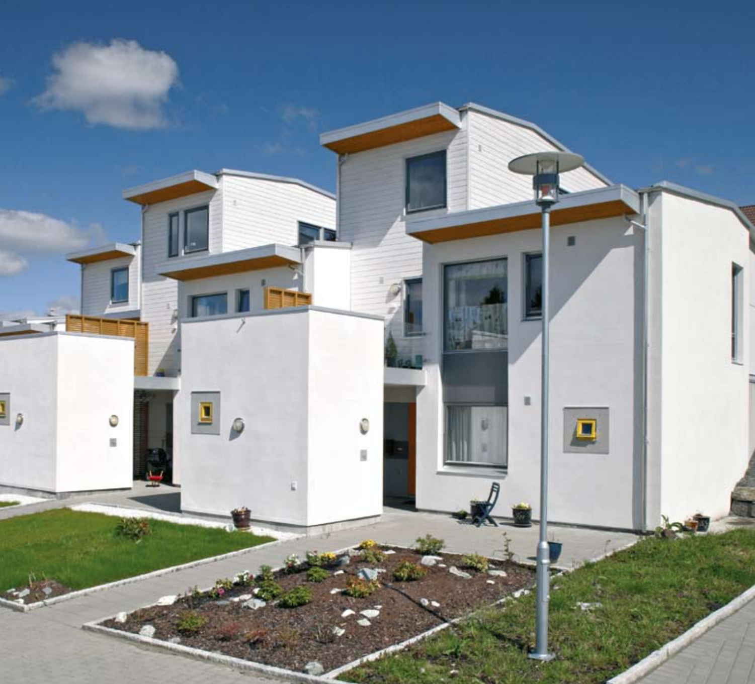
R22-25; inngangsfasaden mot vest
