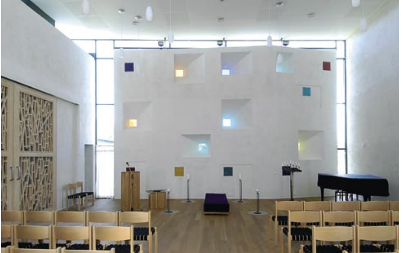
Seremonirommet. Fondvegg og sidevegg er bærende, murt diafragmavegg. Lysinnslipp gjennom tykke murer, pusset på ut- og innside gir assosiasjoner til de 750 år gamle steinmurene i Bodin Kirke.
