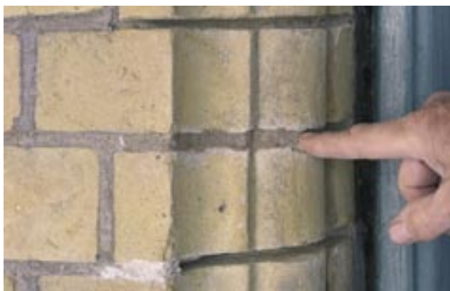
fig. 3 Ny fugemørtel i vindussmyget sett i forhold til fasademørtelens farge. Fugene ble krasset ut i ca 2 cm dybde
