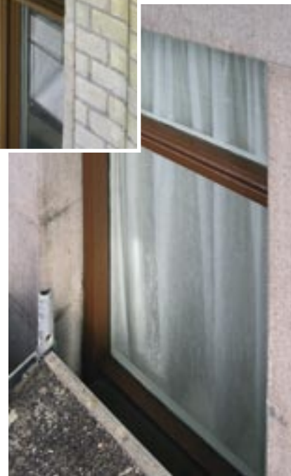
fig. 12 Den litt mørkere farge på vindu og port i granittsokkelen
