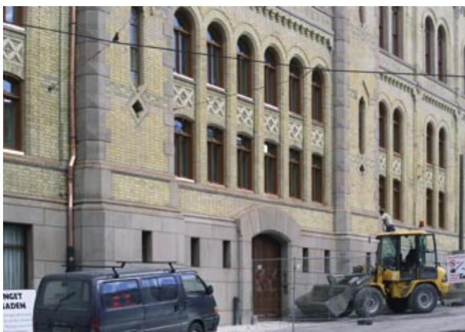
fig. 14 Midtre del av fasaden da stillaset var tatt ned
