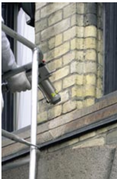
fig. 9 Test av rensing med laserimpulser. Effektivt men dyrt. På en overflate som denne kan man regne med en fremdrift på ca 1 m 2 i timen
