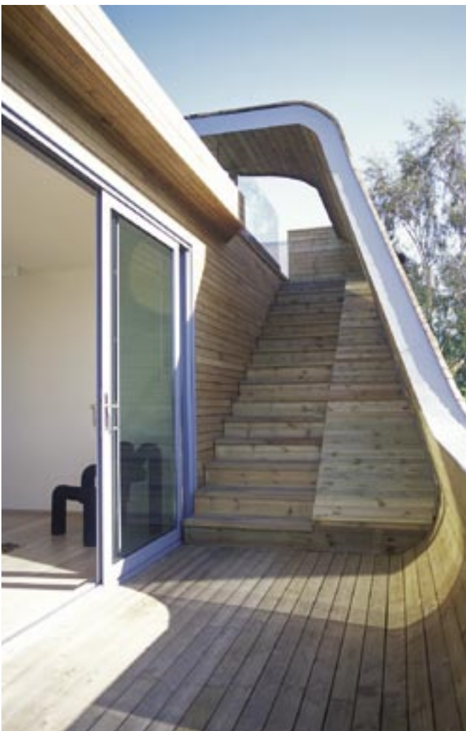
Trapp til takterrassen fra verandaen i 2. etasje
