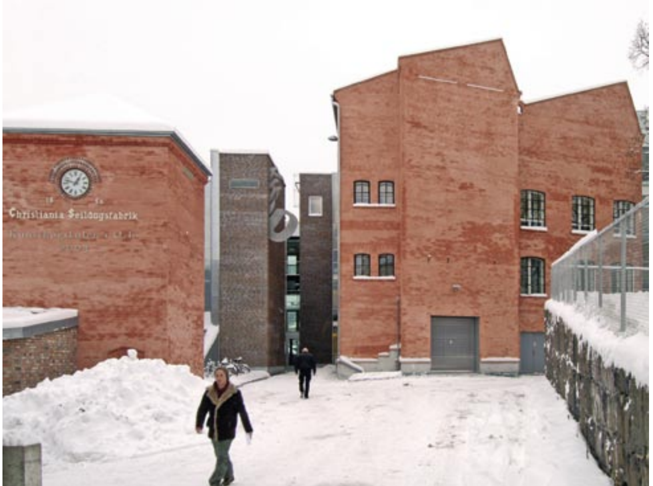
Fra inngangspartiet mot øst, med de to verneverdige bygningene i slemmet tegl
