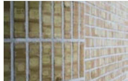
Teglsteinen er murt med baksiden ut
