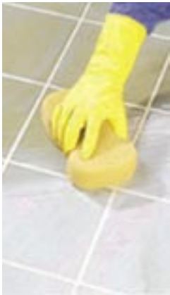
Fugemassen er flatens svakeste ledd og må velges med omhu
