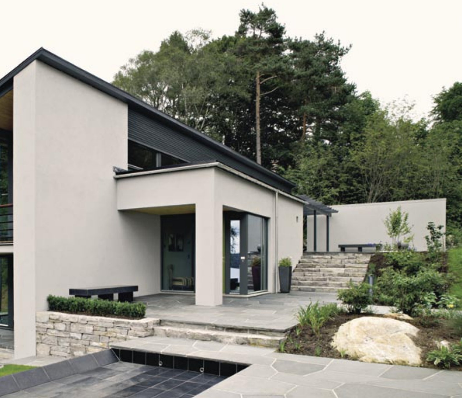
Vannspeilet ved fremre terrasse får vannfall ut til to sider
