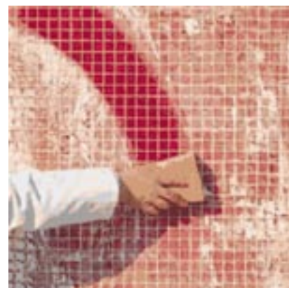
Figur 3: Godt resultat oppnås ved å bruke hvite, finkornige fugemasser uten kvartssand.
