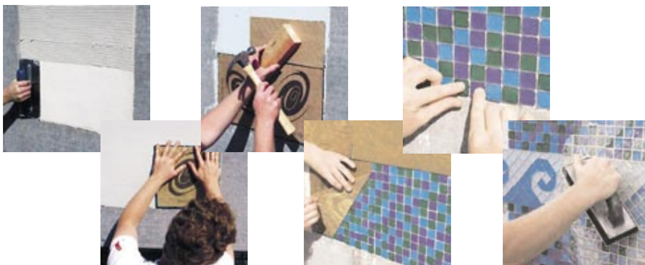
Figur 1b: Oppsetting av mosaikkark med papirfolie på forsiden. Papirfolien fjernes ved at den bløtes før den dras av
