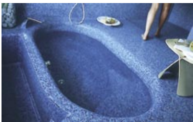
Figur 4: Glassmosaikk er spesielt anvendelig der man skal lage kurver, buer og formasjoner
