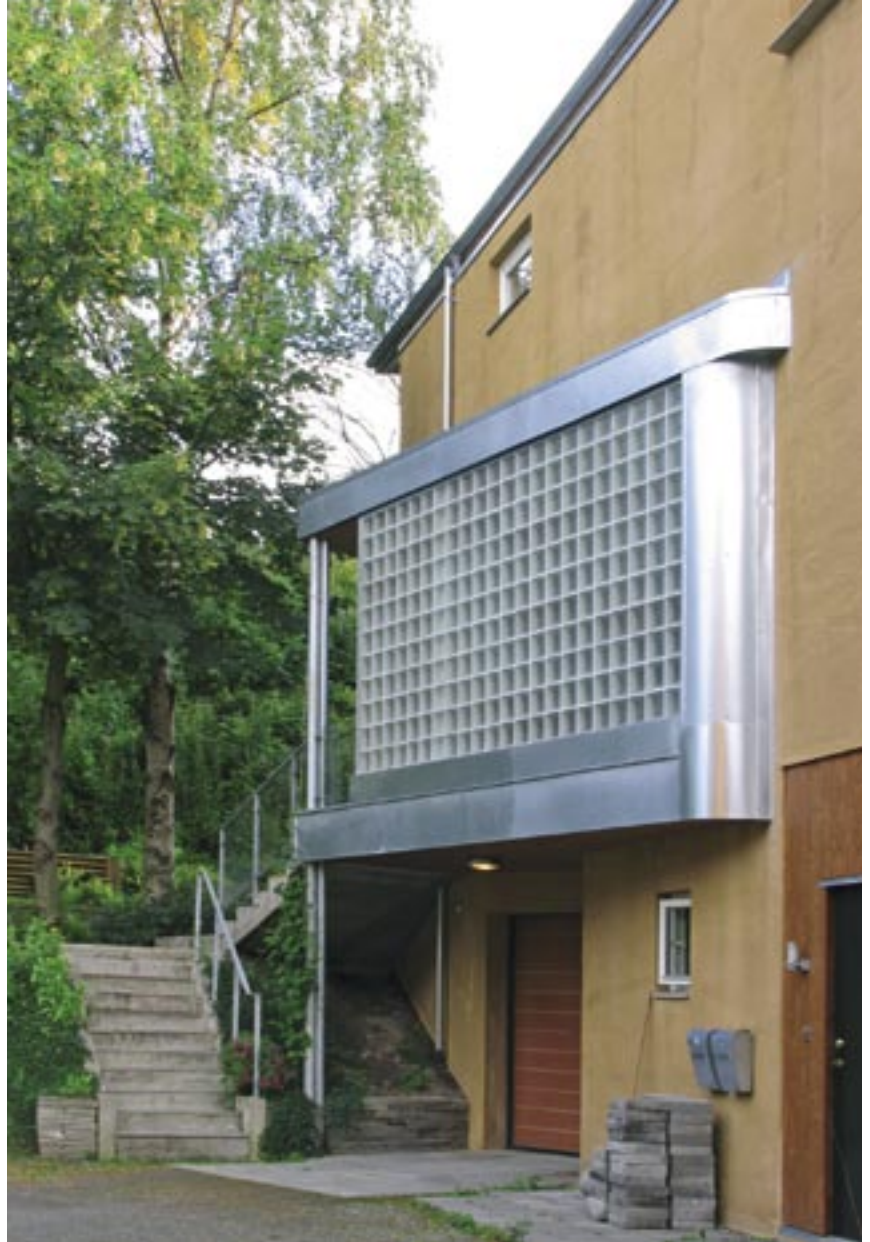
Fasade mot nord med inngangspartiet
