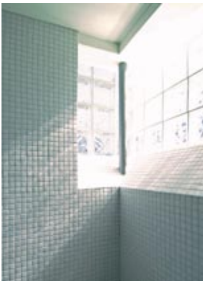
Vindusnisjer høyt på vegg er skråskåret i bunn for å gi et større lysinnslipp. Løsningen gir assosiasjon til middelaldersk byggeskikk.
