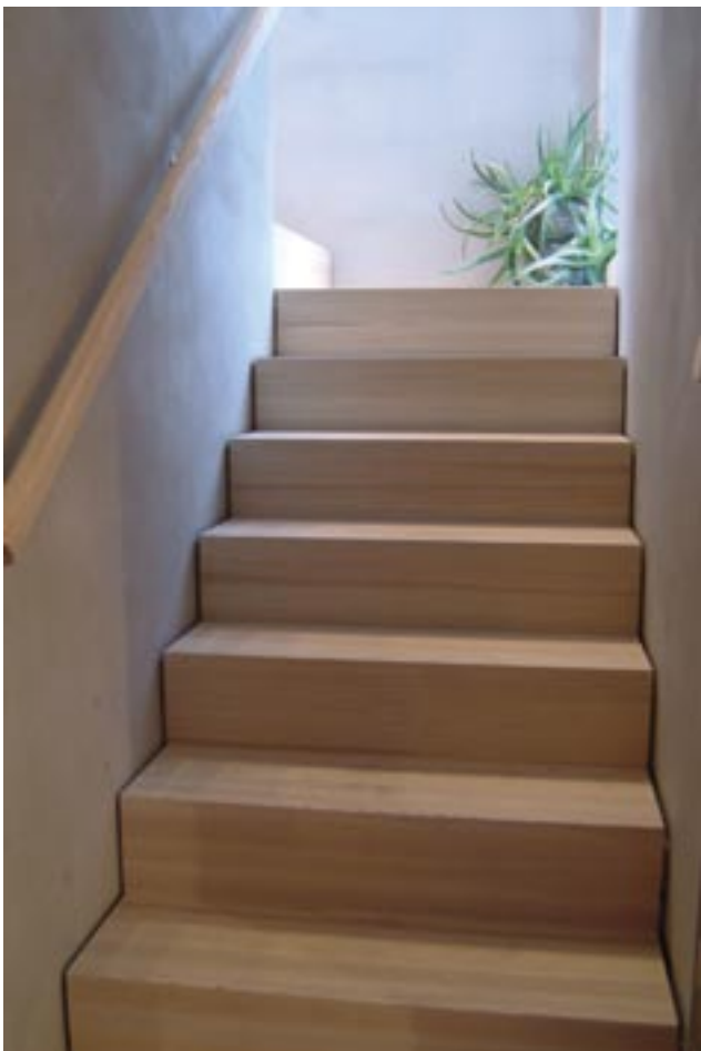
Trapperommet har loddpussete lecavegger med vinduer på to sider av repoet. Trappen er i lys ask.
