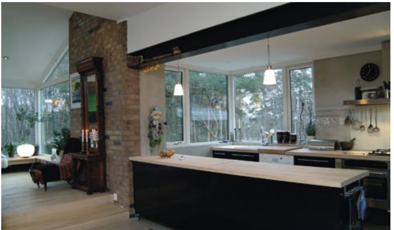
Ståldragerne er synlig i rommene og sortmalte. Her fra overgang kjøkken/stue
