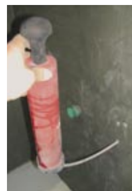
Figur 12: Hullet blåses rent for støv før tokomponent masse presses inn i forborede hull
