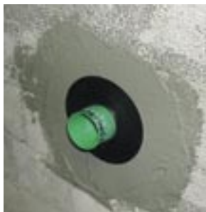
Figur 7: Bruk av gummipakning rundt veggboks
