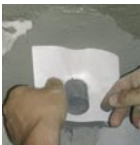
Figur 8: Bruk av rørmansjett
