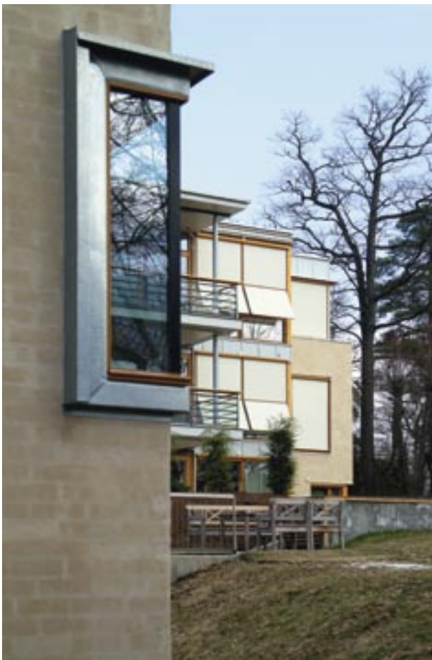
Sørfasade hus A sett fra hus C
