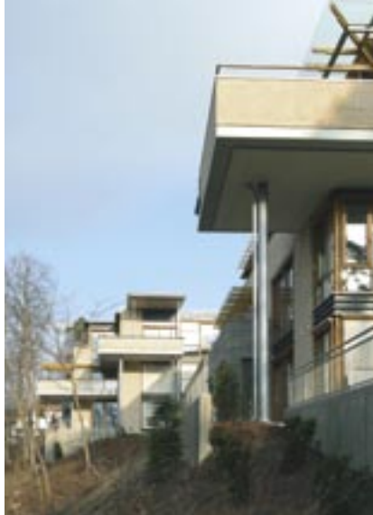
Hus B og C sett fra sør
