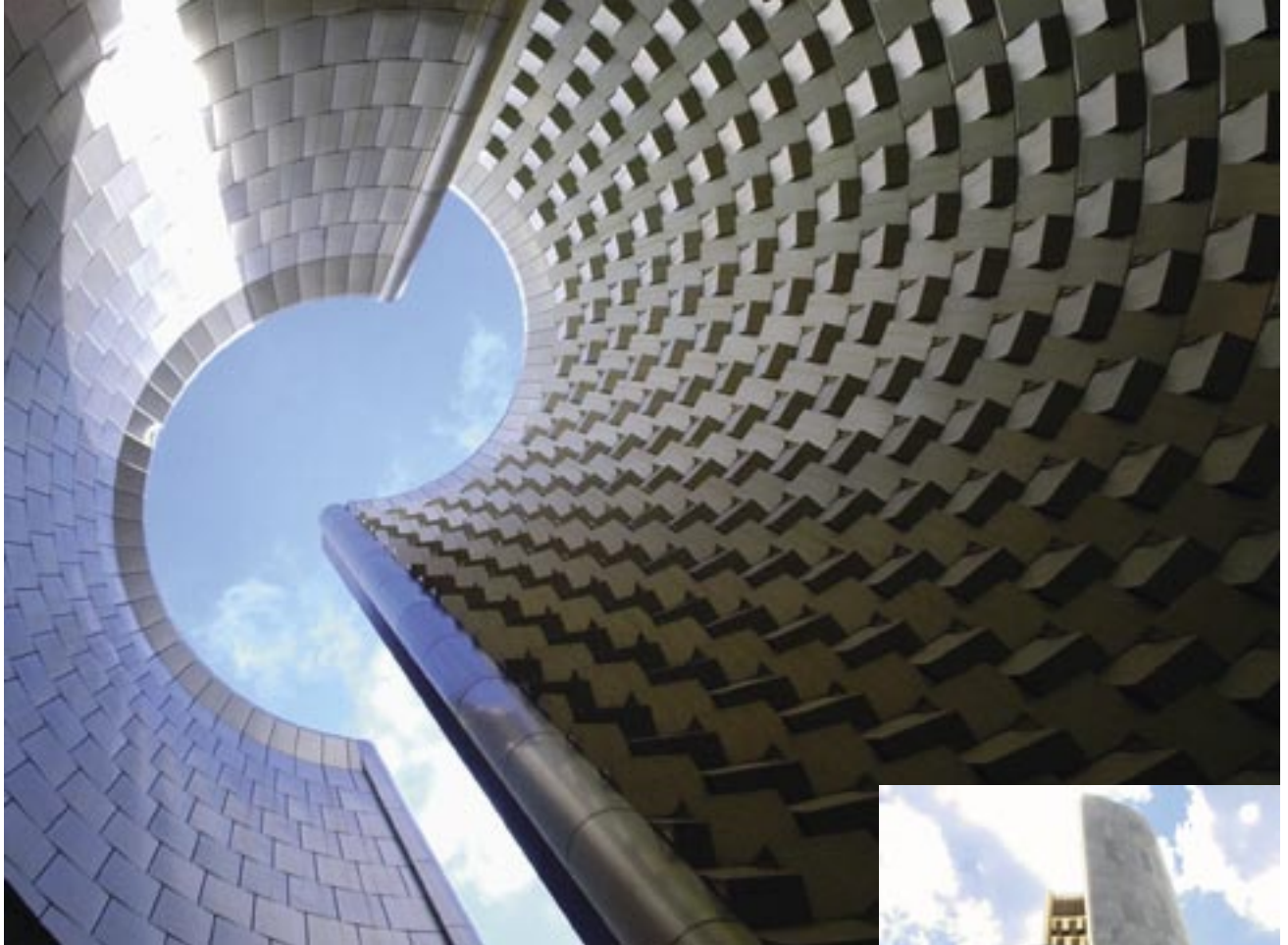
Stålplatene i Le Cône er blitt produsert i Tyskland for så å bli videresendt til Taiwan der de har vært behandlet med titandamp. Fargen varierer med sollysets styrke
