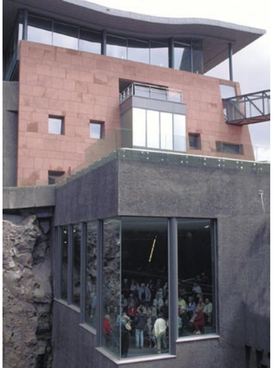
Tre fjerdedeler av strukturen er lagt under jorden
