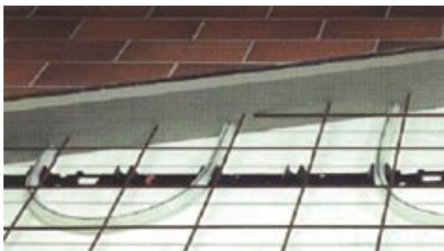
Figur 2: Rør i rørholderskinner
