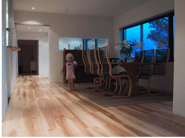
Fra stuen. Innvendig er murveggene finpusset, og gulvene er i heltre ask.
