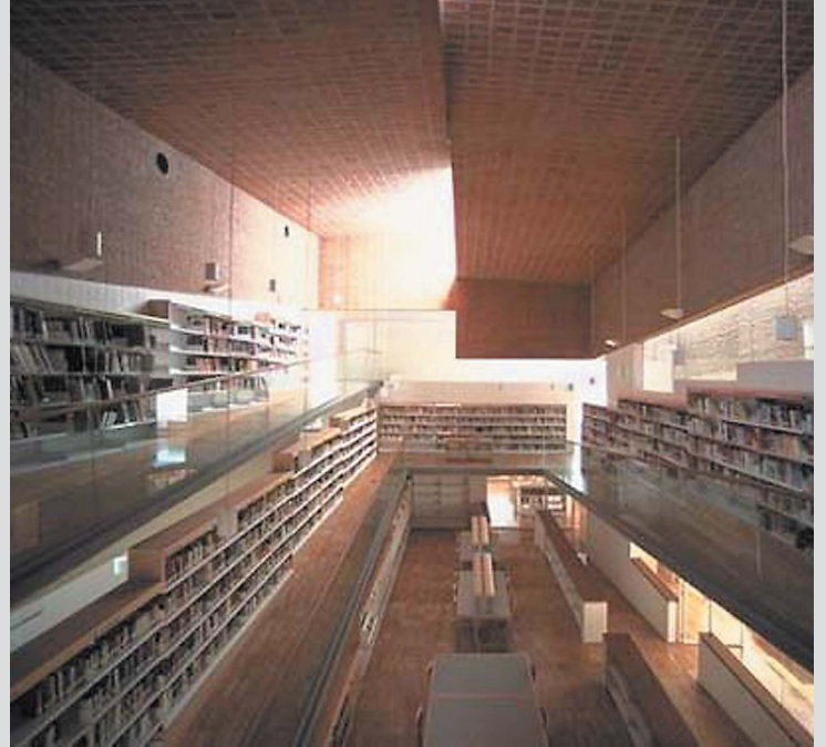
Teglsteinen er med som et konstruktivt bærende element
