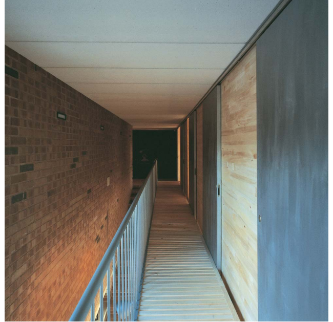
Adkomstbalkong til soverommene. Dekkeelementene av siporex er benyttet ubehandlet, men planlagt slik at de går opp med bygningens mål.
