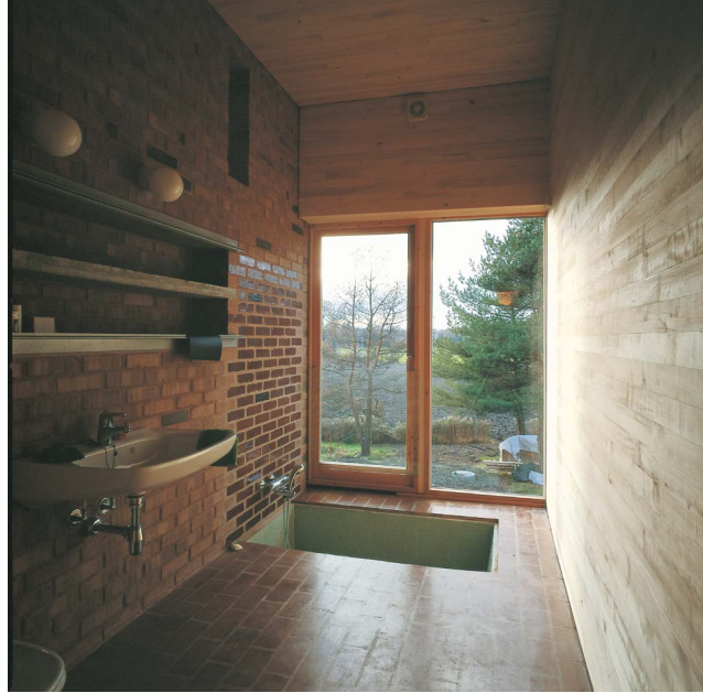
Badekaret i prefabrickert betong er nedfelt i gulvet og innvendig kledd med glassmosaikk. Veggene bak badekaret har glassert tegl og vanntette fuger. På badet er teglgulvet slipt og vokset.
