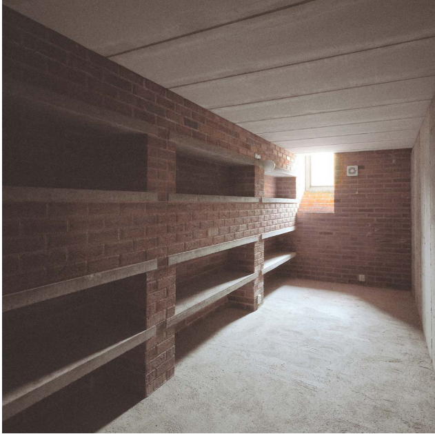
Størstedelen av husets oppbevaring består av prefabrickerte betonghyller som er murt inn i teglveggene.
