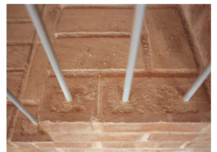
Rekkverket til den innvendige trappen er satt ned i kanalteglens hull og festet med ekspanderende betong.
