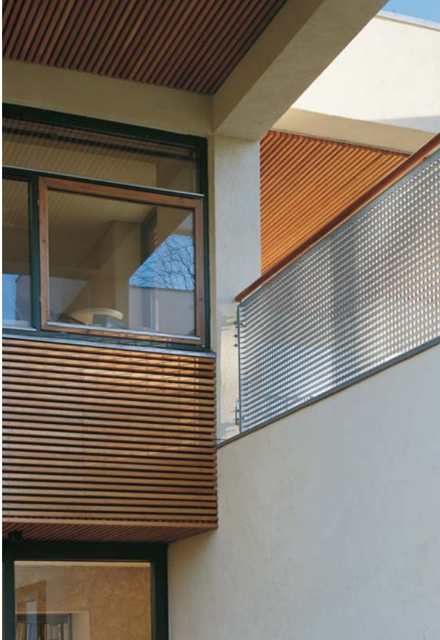
Detalj av materialoverganger mellom mur og trevirke, stål og glass, mellom vegg og himling, rekkverk og vinduer
