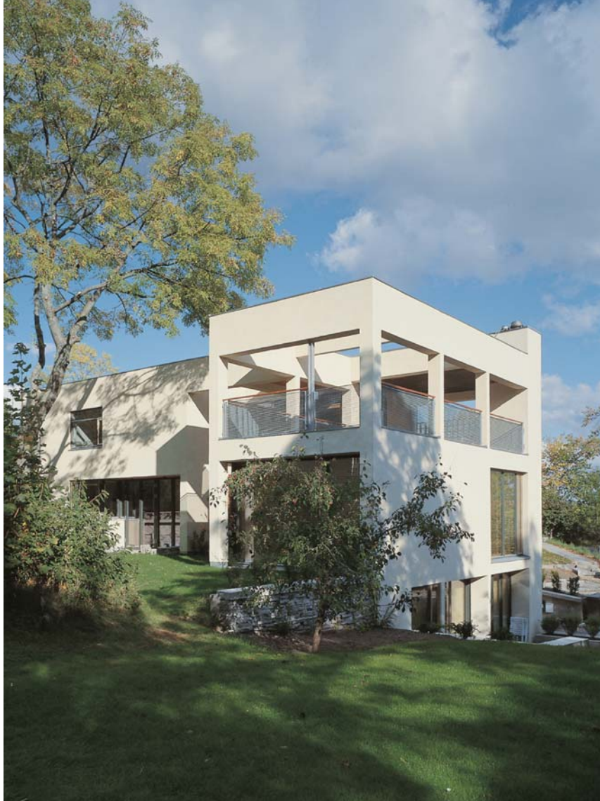
Åpen takterrasse skjermet av murkonstruksjoner, som fullfører den komplette form. Kontakt med trær og busker inne og ute, oppe og nede. Villa Andersen/Sveinsson.
