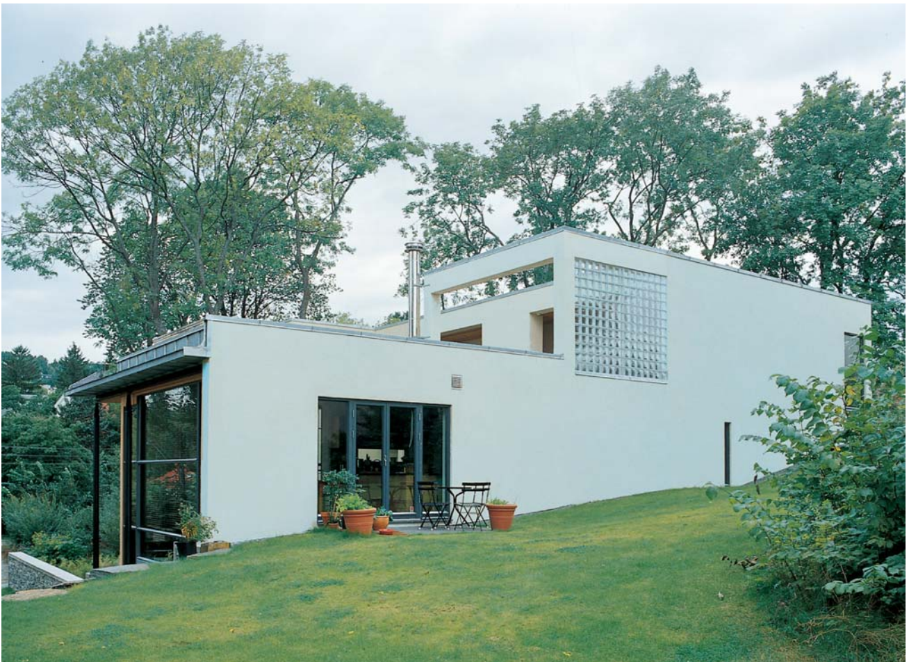
«Tett» murvegg mot naboens uterom. Villa Vest, Slapø/Berz
