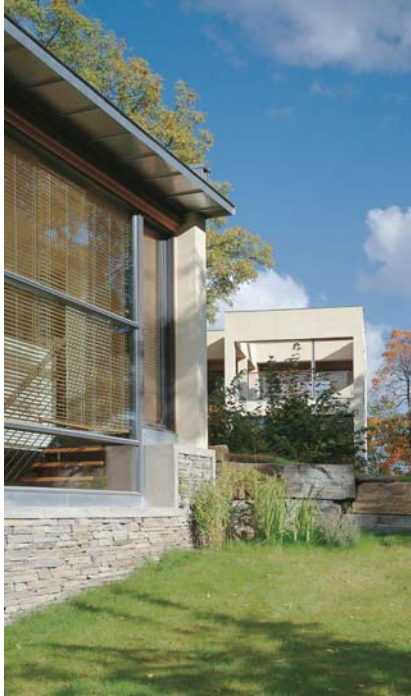
Mur, glass, betong og stein: Fra ett hus til et annet
