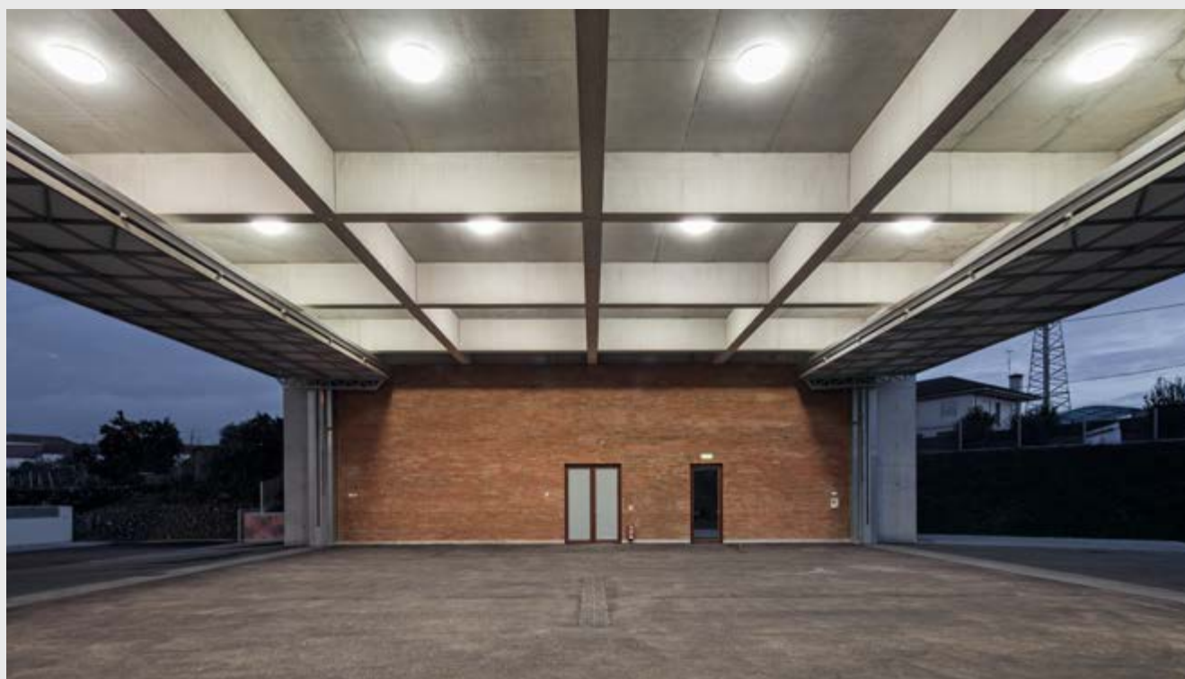
Gjennomgående verksted-/ vaskehall
