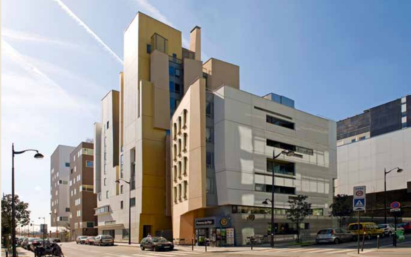
Fasadelementer i pigmentert, slipt betong, Universitetsdistriktet i Paris. Arkitekter: Jean Guervilly, Françoise Mauffret m.fl.
