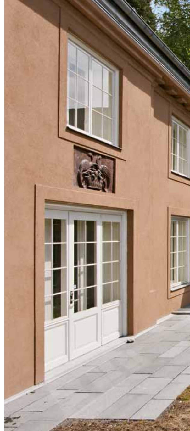
Den bevaringsverdige villaen fra 1920 trengte omfattende rehabilitering. Teglfasaden hadde en grå puss som var i ferd med å løsne. Bak pussen fantes restene av terrakottafarget puss. Gammel puss ble fjernet, og ny puss ble påført i den opprinnelige fargen.
