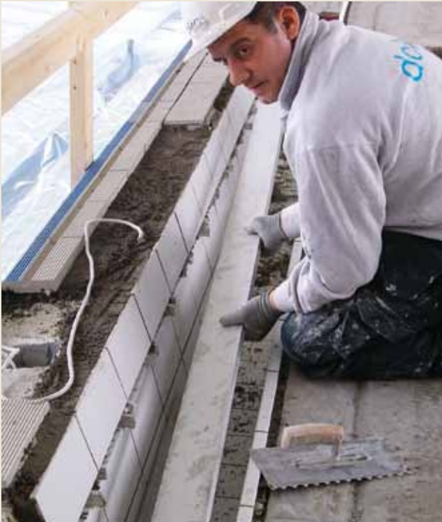
Flislegging av bassenger er presisjonsarbeid hvor mange materialer skal samspille
