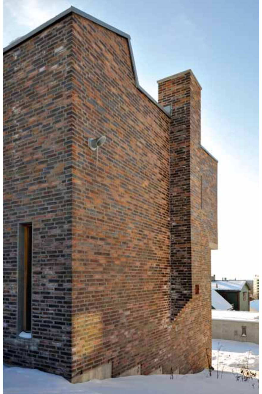
Sett fra nord. Teglsteinen har store variasjoner både i farge og dimensjoner, noe som gir store fugebredder og en grov struktur på veggflaten
