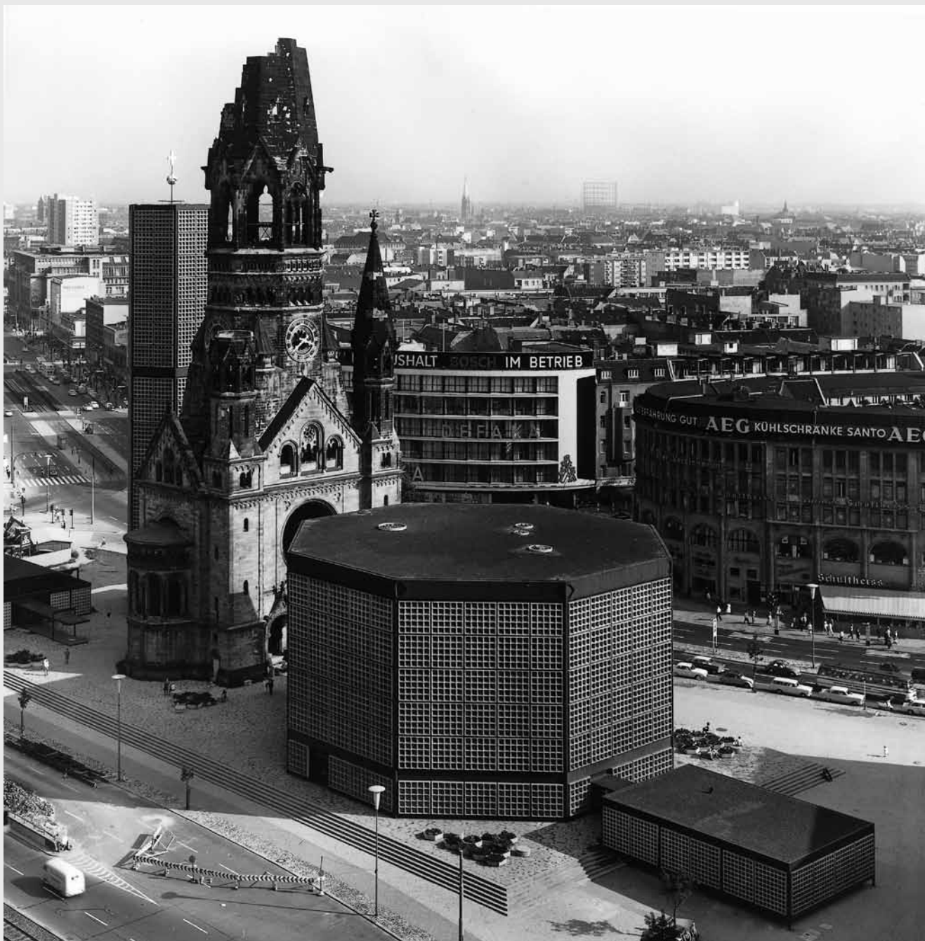
Den opprinnelige kirken ble bombet i 1943. Egon Eiermann lot ruinene av tårnet danne tyngdepunkt i en modernistisk komposisjon hvor han tilførte fire geometriske volumer: et større frittliggende rektangel som rommer menighetssalen, et sekskantet tårn, et åttekantet kirkerom og et mindre rektangel for kontor og sakristi. Foto: saai, Horstheinz Neuvendorff
