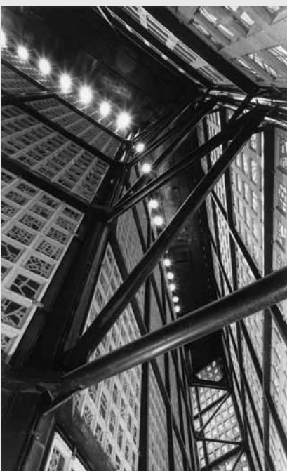
Den doble ytterveggen har glassmalerier ute og inne. Mellomrommets lamper gir toveis belysning. Et stålfagverk forbinde og stabiliserer veggene og danner en ringdrager i topp og en avstivende ditto ca 4 meter over gulvet. Her er yttervengen tett (betong istedenfor glass)
