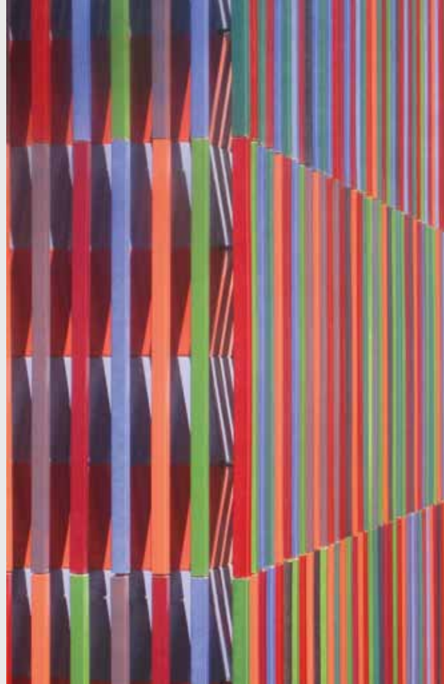
4 x 4 x 110 cm glaserte keramiske staver er festet med klips på baksiden. Stavene er plassert vertikalt foran og med avstand til vannrette, tofargede metallplater som hver for seg er tiltet. Slik forsterkes skyggespillet. Foto: Bitte Osnes Dahle
