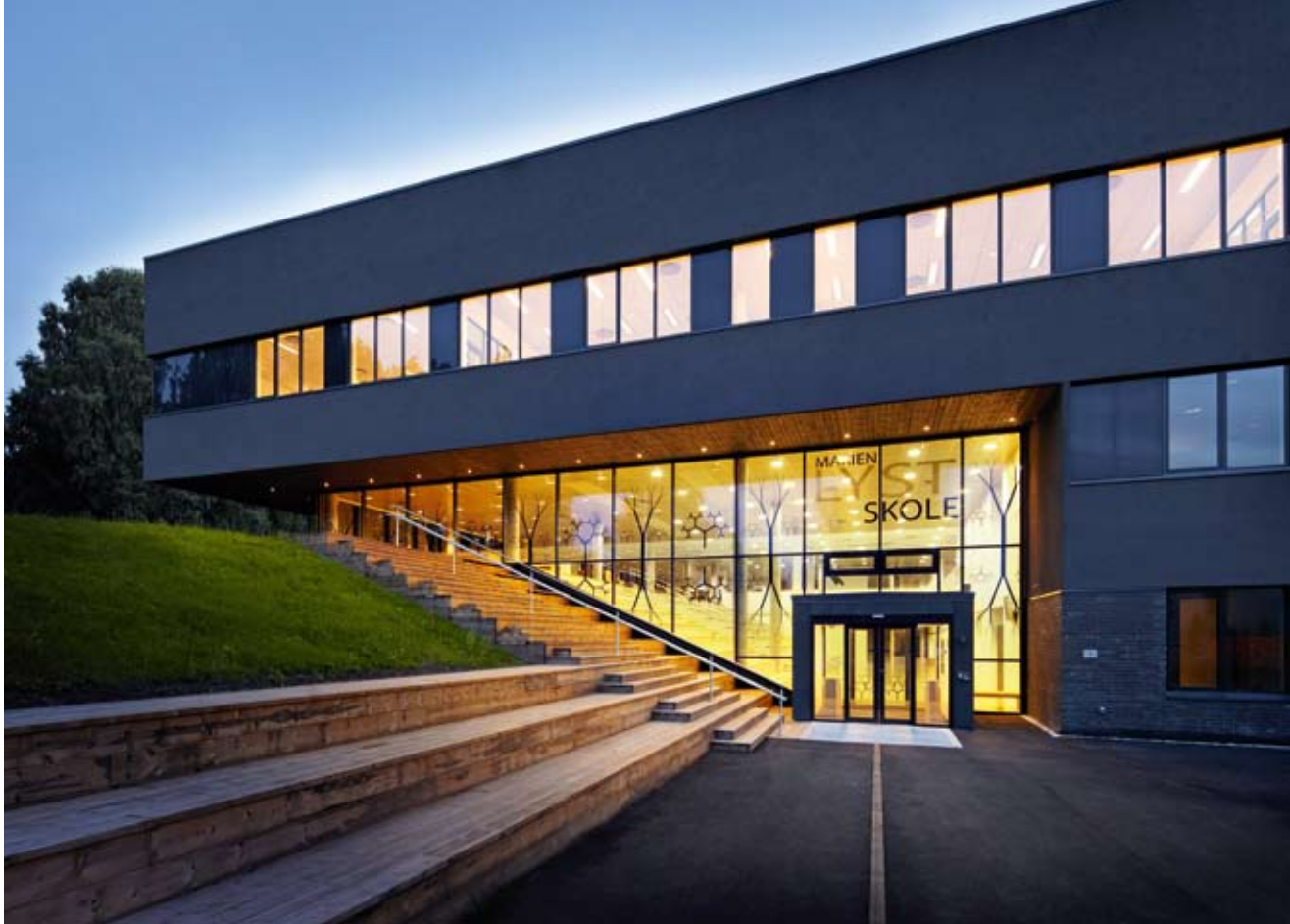
Fasade mot nordøst med hovedinngangen. Innenfor ligger det store rommet med amfi. Skolen har pusset fasade med vindusbånd i 3. etasje, møblert terrasse med tredekk og amfi i 2. etasje og teglsokkel i 1. etasje
