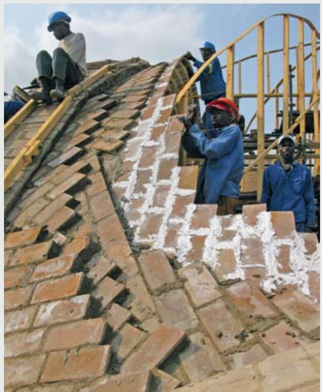
De dobbelstkrumme takene er bygget som hvelv med fire krysslagte sjikt
