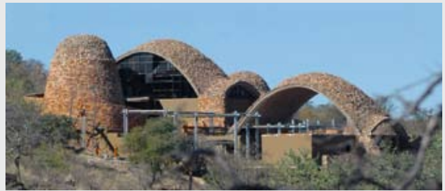
De dobbelstkrumme takene er bygget som hvelv med fire krysslagte sjikt
