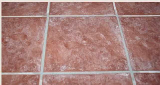
Figur 6: Når fugemasse er ferdig uttørket blir den lysere. Den skal da gå i ett med eksisterende fugefarge
