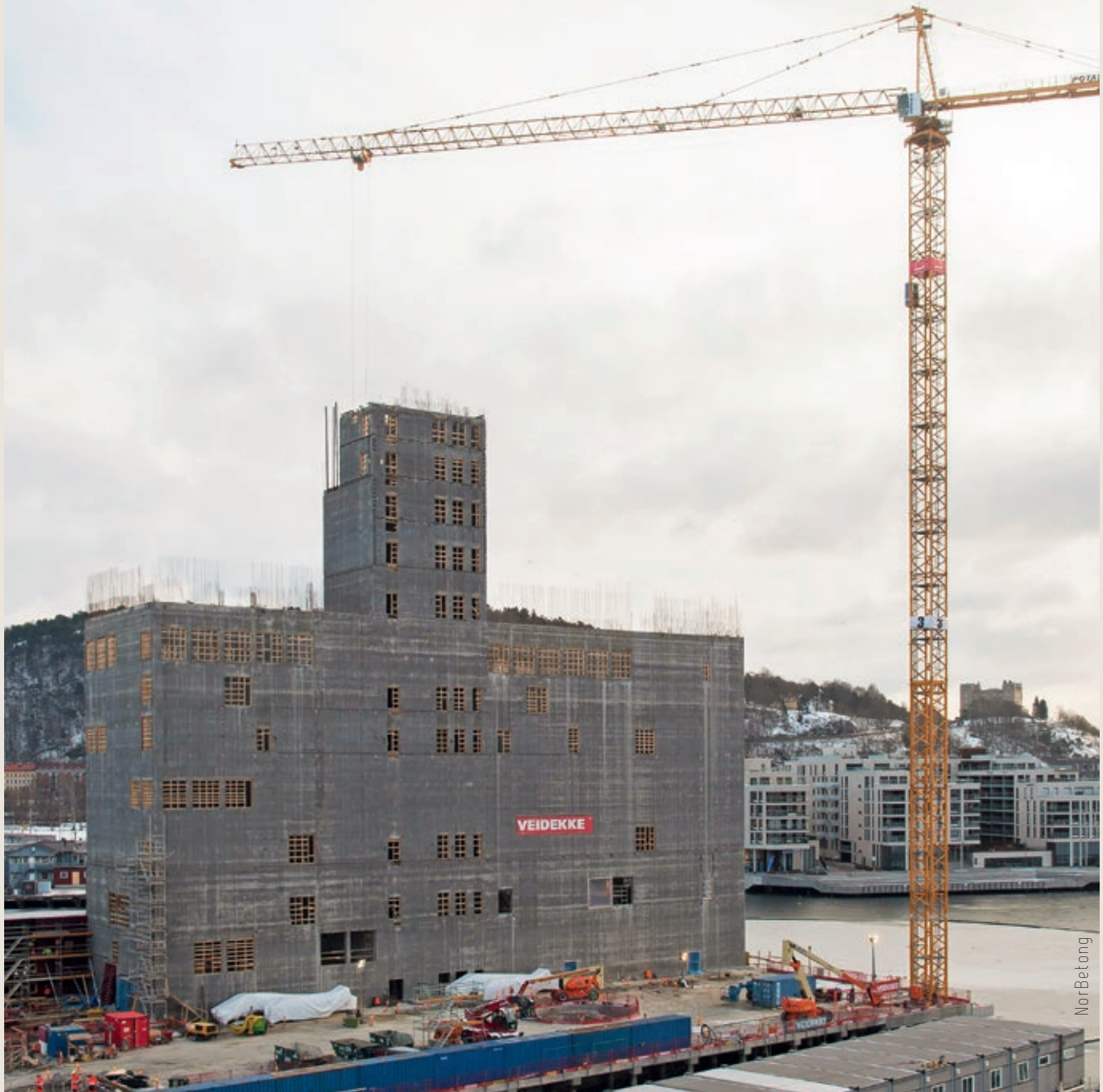
Sett fra vest, med Sørenga i bakgrunnen. Den statiske, lukkede delen av museet der kunsten skal bo, er støpt med glideforskaling
