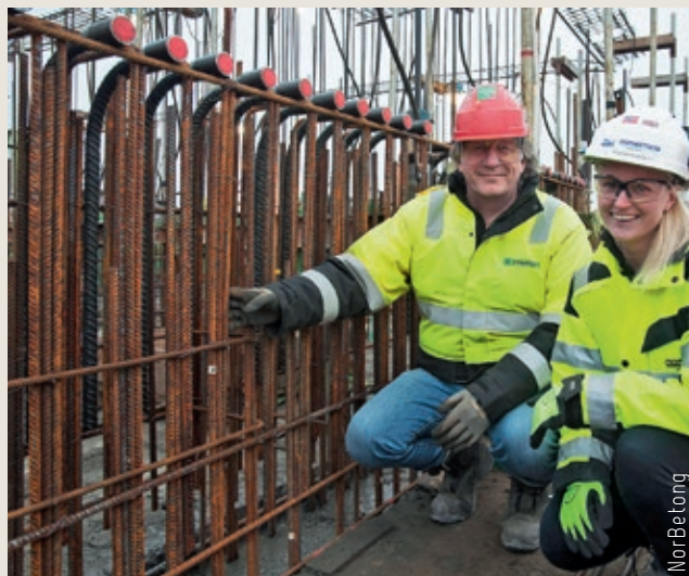
Skjøtehylser til innfesting av dekker. En stor mengde hylser skal inn på én og samme elevasjon, og feilvinkling må unngås
