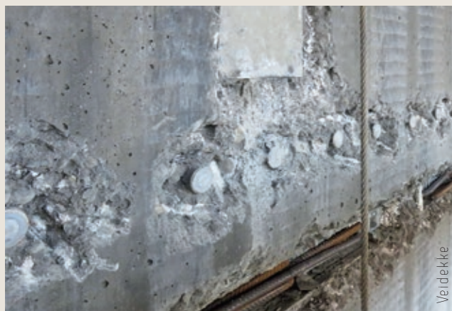
Skjøtejern pigges fram under formen.
