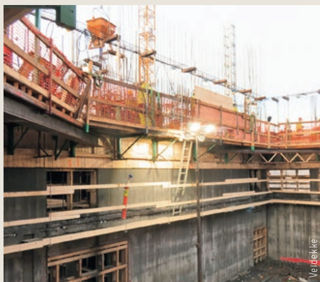
Under selve glideformen er det montert et hengestillas. Herfra utføres arbeidet på den ferdige betongen. Hovedarbeidet er å pigge fram skrukoblinger og skjøtehylser som skal brukes i etableringen av dekkene etter gliden. Stålplater og elektrokomponenter må også frilegges. Fra hengestillaset flikkes også eventuelle sår i betongen.
