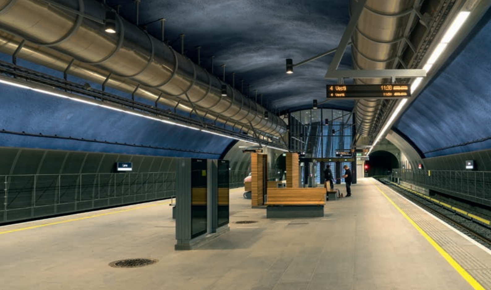
Den 120 meter lange toghallen har et buet hvelv av blåmalt sprøytebetong på utsprengt fjellprofil
