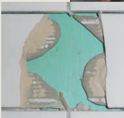
Figur 5: Limet skal kammes ut på underlaget, ikke legges på flisen alene som her
