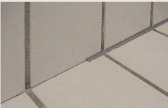
Figur 2: Der må være plass til fugemassen. Fugemassen må ligge inni fugeåpningen, ikke kun utenpå
