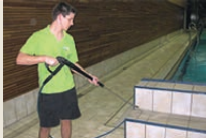
Figur 8: Rengjøringsmetoden er avgjørende for bestandigheten av fugene. Kraftig høytrykkspyling, harde hjul og stive børster reduserer fugenes levetid.
