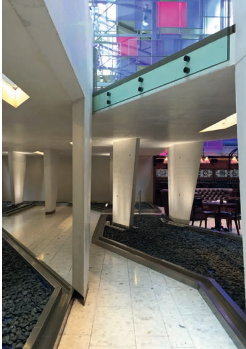
Asymmetriske, skrå hjørner kombinert med kompleks geometri og vegger/vanger med tykkelse på 18 cm krevde stor nøyaktighet i forskalings- og støpearbeider
